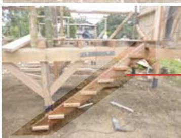
Vista transversal de la estructura prefabricada de la escalera. Sobre los cuartones (pieza E2) se apoyarán y fijarán los escalones
